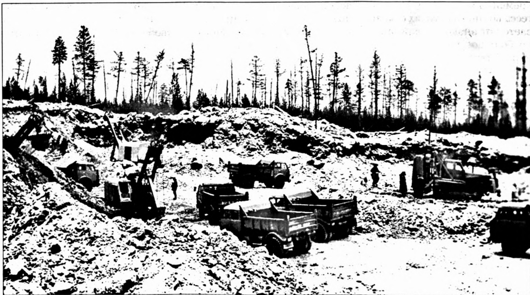
Ноябрь 1974 года. Амурская область. Отсыпка земляного полотна на строительстве железнодорожного участка между станциями Бамовской и Тындой
